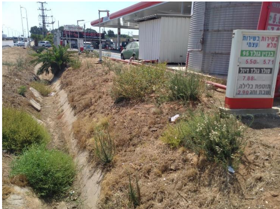
תמונה 1 – תעלת ניקוז מבוטנת שמפרידה בין כביש 2 לתחנת הדלק.
